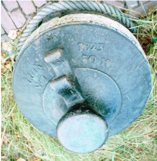
Afb. 524 De eerste 30-ponder type 1 van 1823, No 1, in gebruik als meerbolder in Middelburg (2000). De 30-ponders hebben een oog aan de kulas voor het broektouw, maar tegenwoordig mist altijd de sluitbeugel. De druif is afgeplat bij de 30-ponders. - Fig. 524 The first type 1 30-pounder dated 1823, No 1, in use as a mooring bollard in Middelburg (2000). The 30-pounders have a loop on the breech for the breeching rope, but today, the closing bracket is always missing. The cascabel is flat on the 30-pounders.
