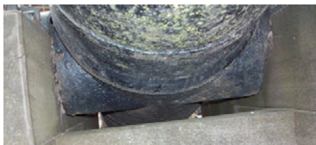
Afb. 438 Tapborsten aan het Carron-kanon te Arcen. Ze sluiten mooi aan tegen de rolpaardwangen. - Fig. 438 Trunnion shoulders on the Carron gun in Arcen. They line up nicely with the sides of the carriage cheeks.
