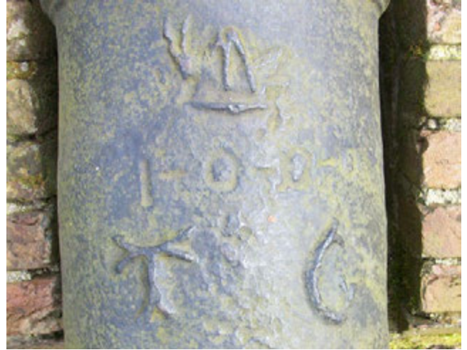
Afb. 131 Tussen de krekel en de initialen staat het gewicht. - Fig. 131 The weight is shown between the grasshopper and the initials.
